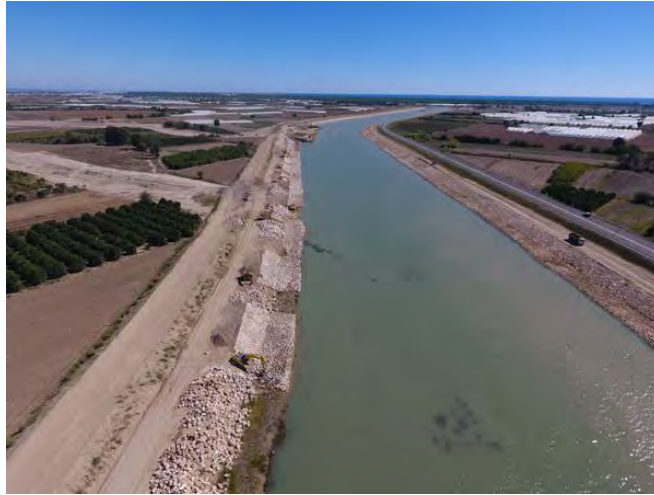
Foto 4: Aksu çayı taşkın koruma çalışmaları devam etmektedir.
